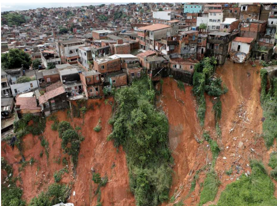
Deslizamento de terra.
